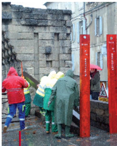
Test de mise en place de batardeaux
